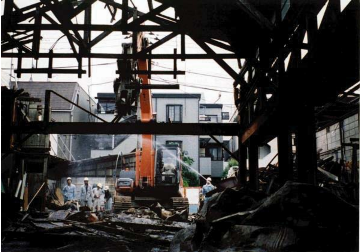
アスベスト撤去後の現場
