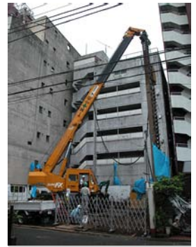
山留工事:親杭H鋼打設。 当該現場は掘削深度GL-4.1m、地質がGL-2.5mより砂礫層のためセメントミルク工法を採用した。
