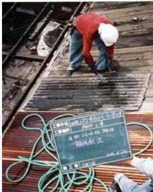
手こわしによる屋根のスレート板撤去作業。湿潤化してからビスを抜き1枚ずつはがして丁寧に運び出した。
