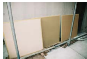
塗り壁の仕上げ見本。品川の現場にて。
