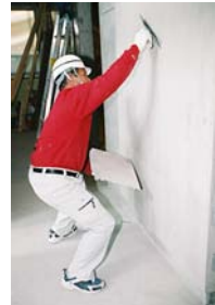
作業中の職人さん。 作業は腰がポイント。
